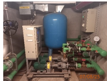
ลักษณะถังเก็บน้ำชั้นดาดฟ้า และ Booster Pump ของแต่ละอาคาร
