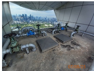
ลักษณะถังเก็บน้ำชั้นดาดฟ้า และ Booster Pump ของแต่ละอาคาร
